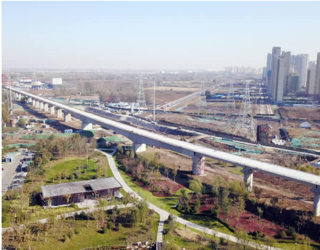
近日,在小清河南侧,黄台联络线长约1000米的高架箱梁已经吊装到位。自9月19日,黄台联络线全线首个跨工业北路高架百米连续梁合龙后,北园高架以北的桥梁也由东向西逐步推进,为后续向济南东站方向运架梁打通了关键通道,标志着距离胶济线明年牵手济青高铁、黄台联络线实现通车更近一步。根据规划,黄台联络线起自济南站,接入济青高铁济南东站,新建正线长度10.469公里。其中,黄台联
